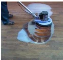
1a Das **Pflegeöl** sehr gut in allen Richtungen verteilen und mehrmals mit **grünem Pad** gut einmassieren (schrubben).
