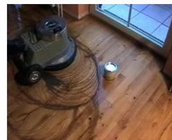
2a erneut etwas Öl ausgießen und den Boden reinigen.
